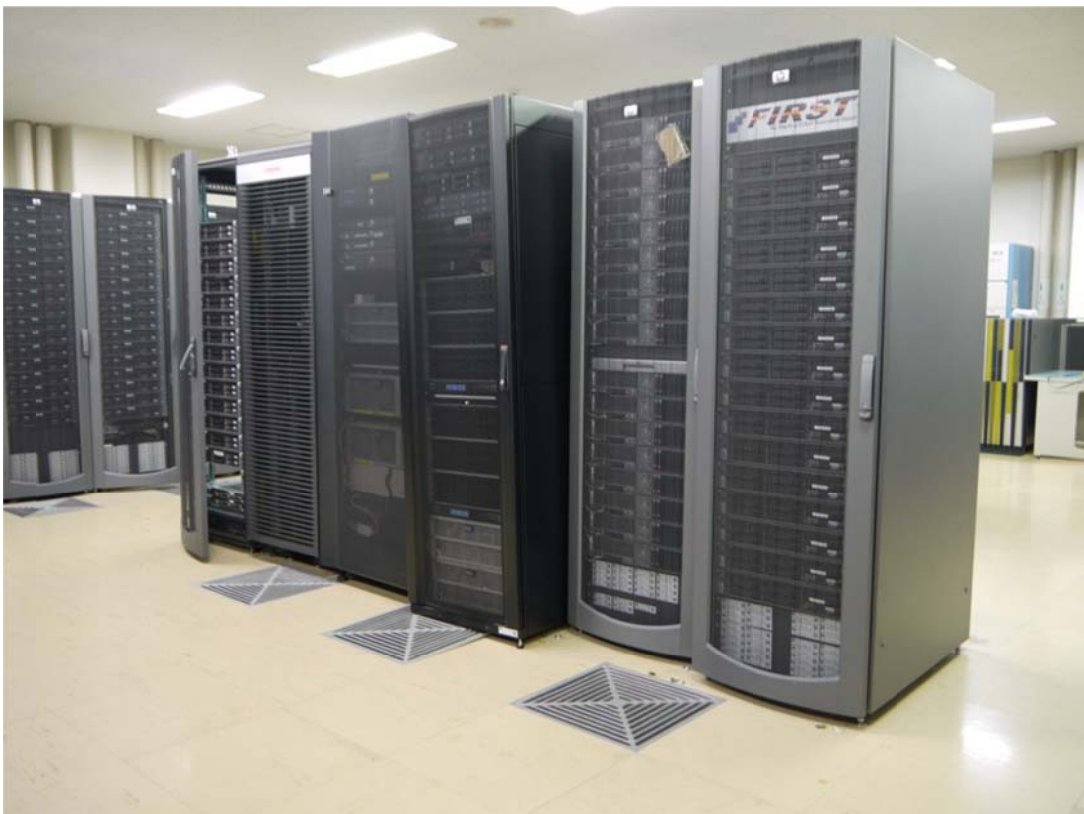
FIRST およびその他のサーバー類は、かなりずれた模様です。<撮影：3月14日(月)9:58>
